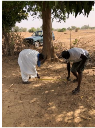
Tracé du diamètre du puits
