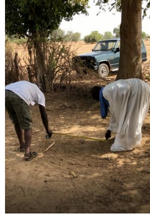
Tracé du diamètre du puits
