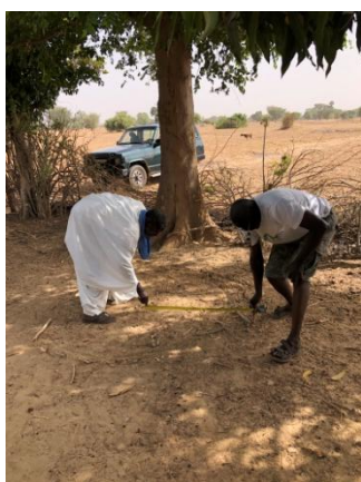
Tracé du diamètre du puits
