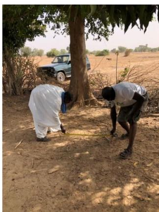
*Tracé du diamètre du puits*
